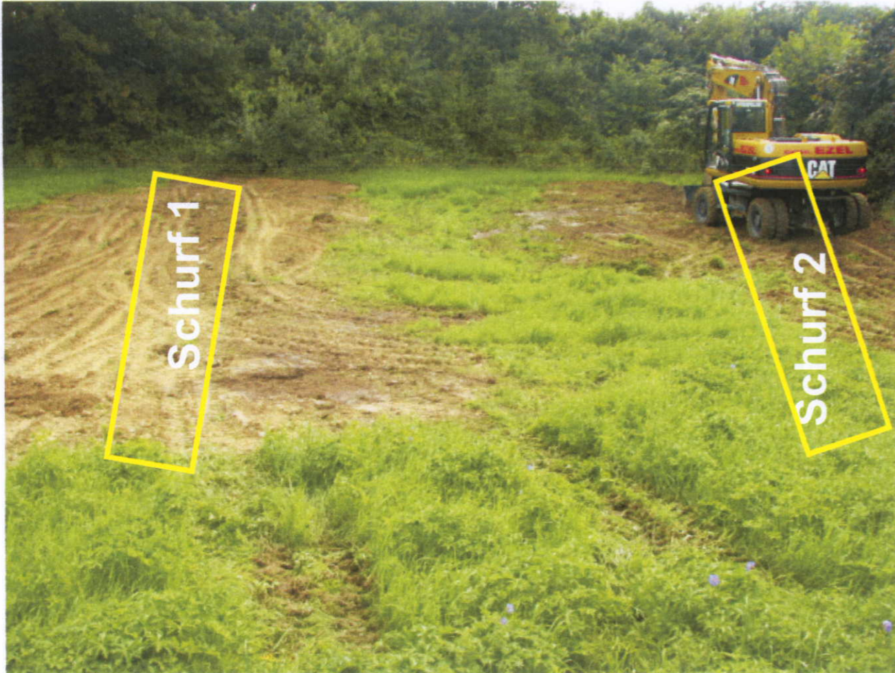
Blick nach Osten auf die beide wieder verfüllten Baggerschlitz 1 und 2, jeweils 30 m Länge
