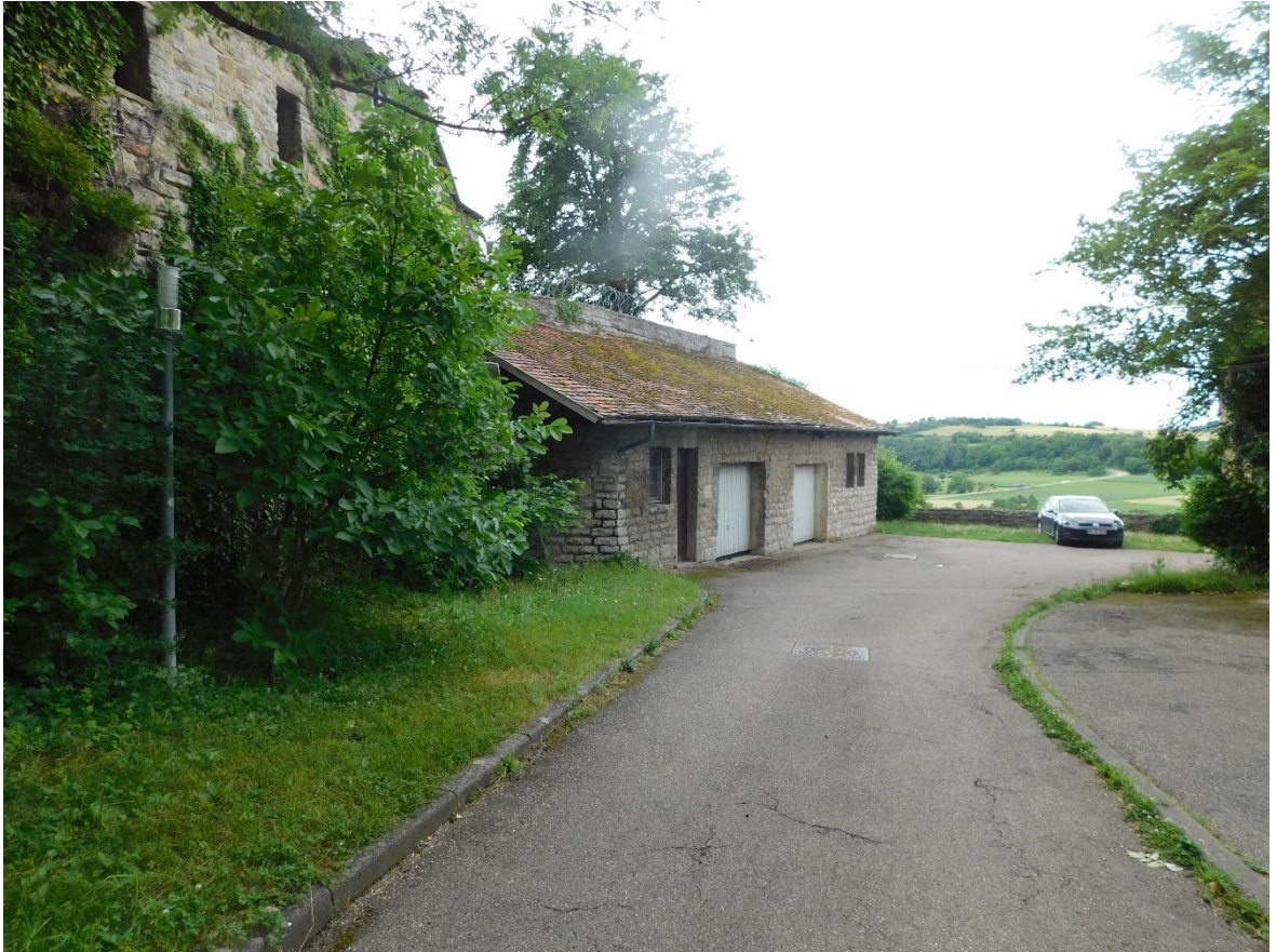
Abbildung 1 Garage nahe der Auffahrt zum Schloss (Abb.1, Geb. 9). Blick nach Südwest
