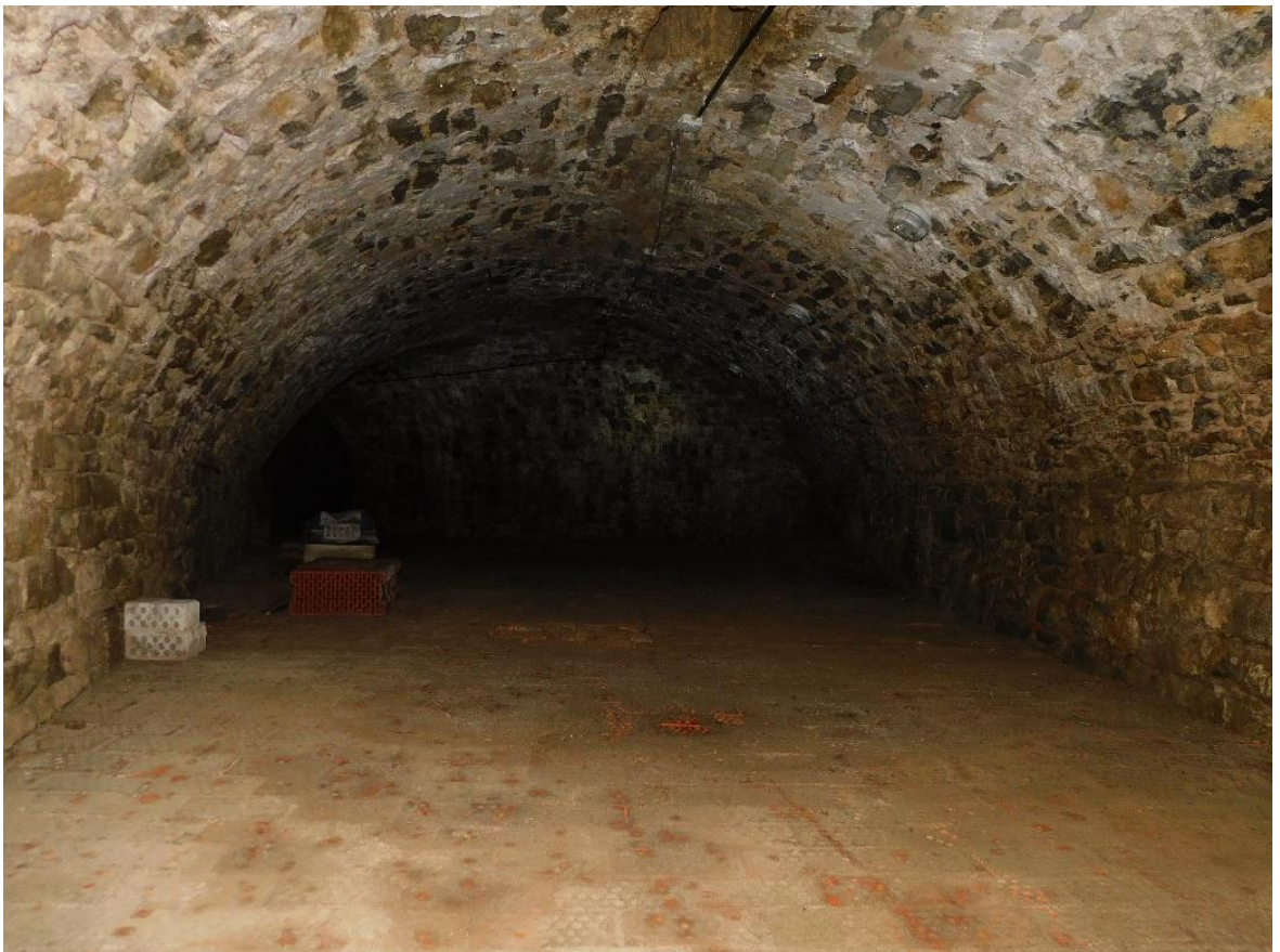
Abbildung 12 Gewölbekeller unterhalb des nördlichen Schlossaußenhofes, ohne Hinweis
