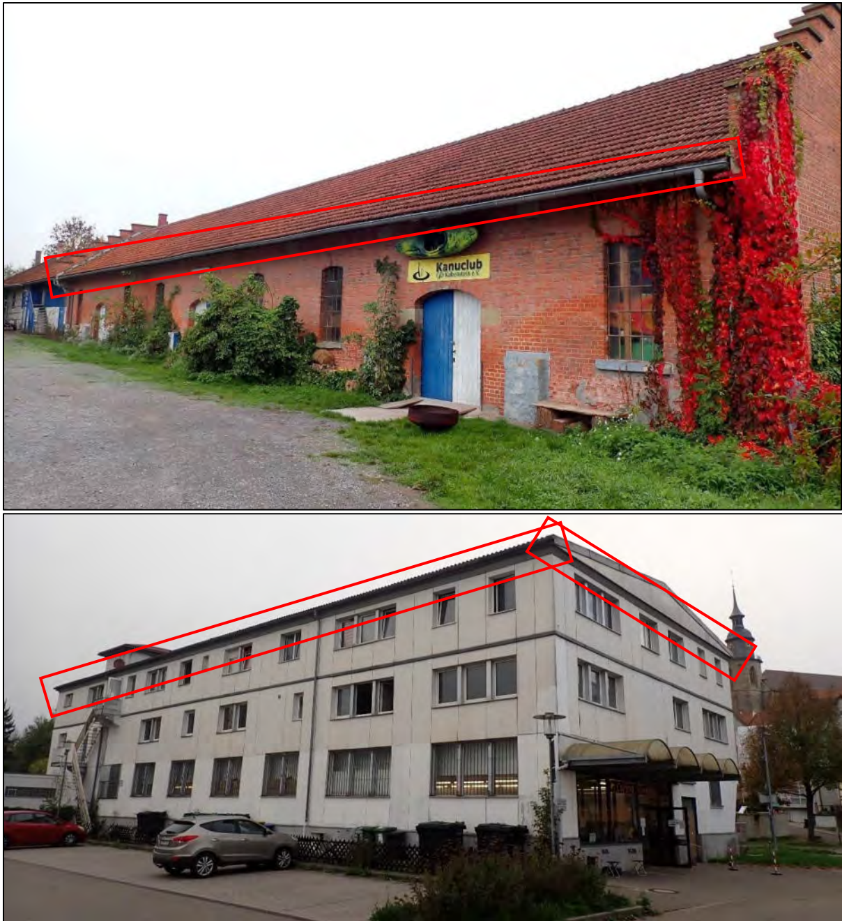
Abbildung 16: Auch die Einflugkontrollen am Gebäude des Kanuclubs (oben) und des Enßle-Gebäudes (unten) ergaben trotz Eignung und potenzieller Strukturen (siehe rote Abgrenzung) für Fledermäuse keinen Nachweis auf Besatz.
