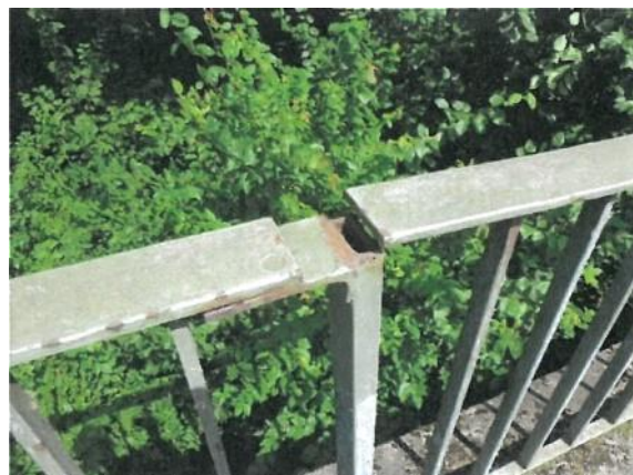
Füllstabgeländer am östlichen Bauwerksrand
