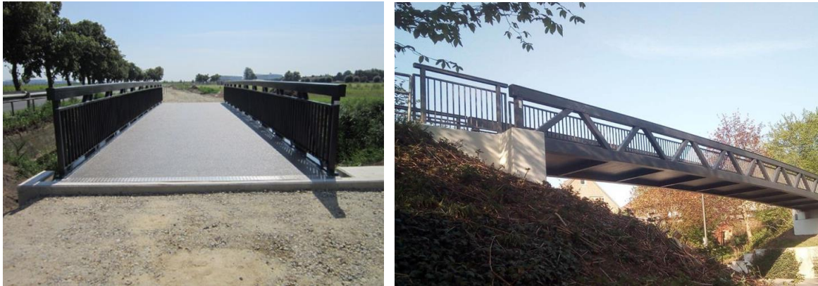
Beispielfotos von Aluminiumtrogbriicken
