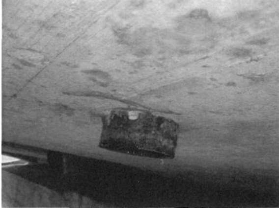
Freifallentwässerung korrodiert
