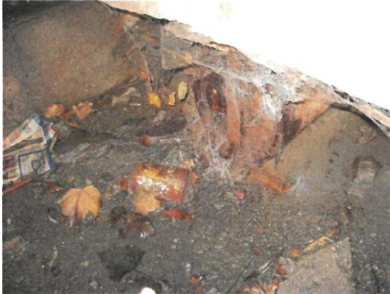
Rollenlager korrodiert
