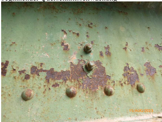
2023_LÄNGSTRÄGER KORRODIERT
