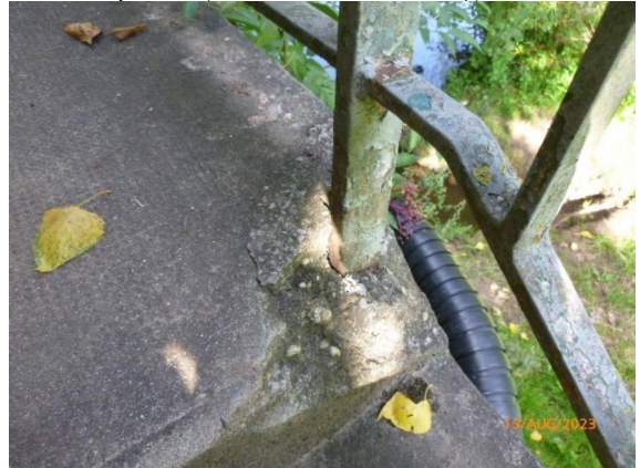
2023_PLATTE BETONABPLATZUNG
