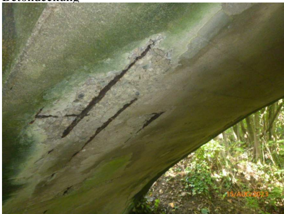
2023_TREPPENABGANG BETONABPLATZUNGEN
