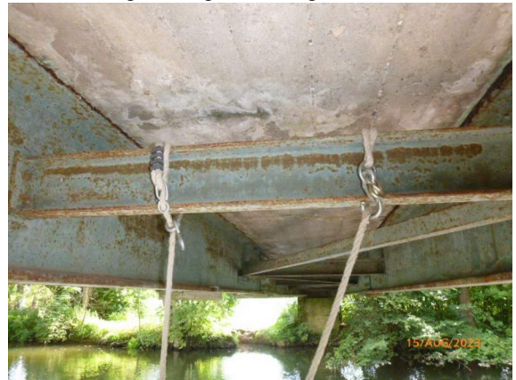
2023_QUERTRÄGER KORRODIERT
