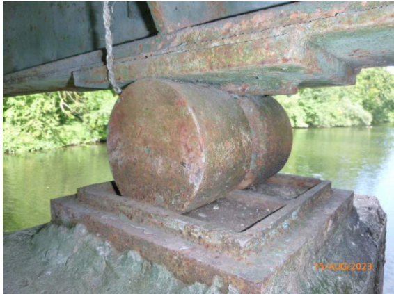
2023_ROLLENLAGER KORRODIERT
