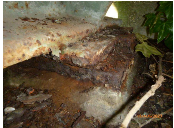
2023_LINIENKIPPLAGER KORRODIERT
