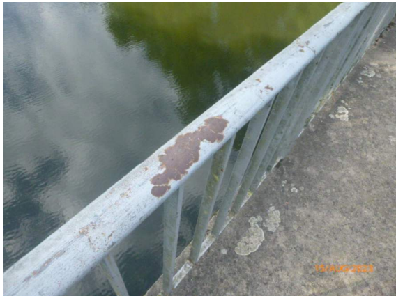
2023_GELÄNDER KORRODIERT
