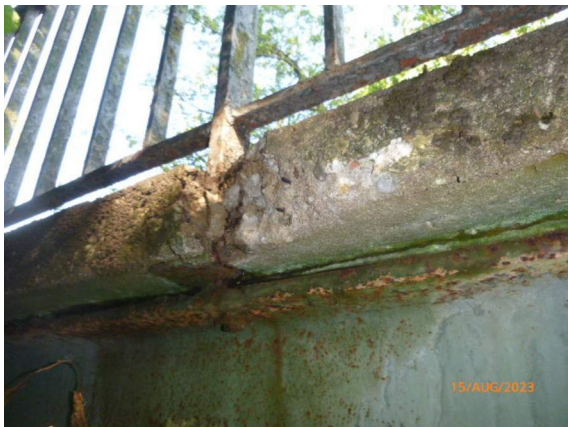
2023_GELÄNDERVERANKERUNG KORRODIERT
