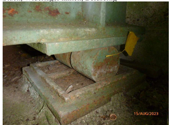
2023_ROLLENLAGER KORROSION
