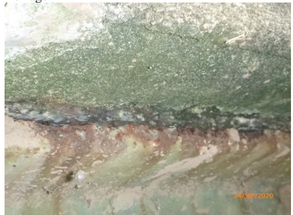
2020_FUGE STAHLTRÄGER UND PLATTE
