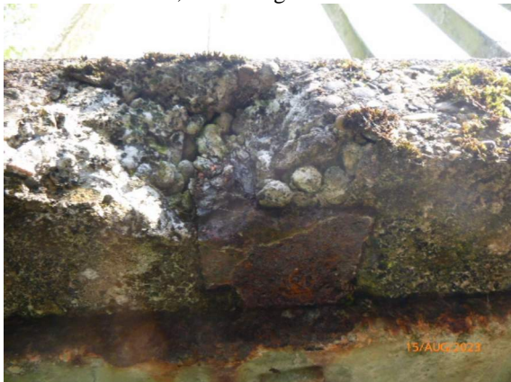
2023_GELÄNDERFUSSPLATTE KORRODIERT
