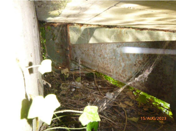
2023_AUFLAGERBANK VERSCHMUTZT
